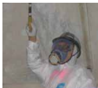
▲吹付けアスベスト除去作業
