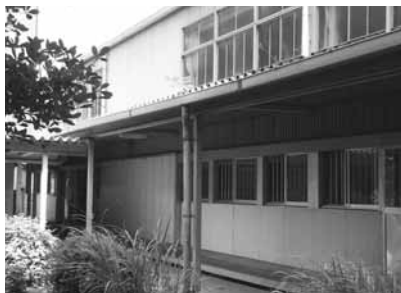
北中学校屋内運動場
