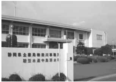
駿豆水道中島浄水場
