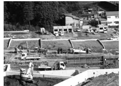
北沢地区の住宅地造成現場
