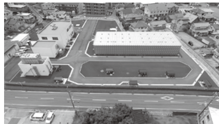
伊豆島田浄水場
