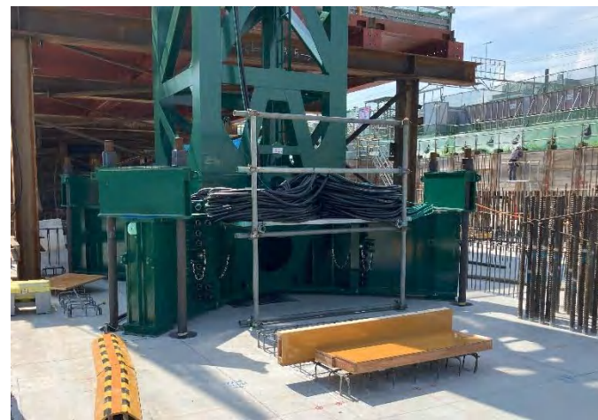
図：タワークレーンの基礎部分
