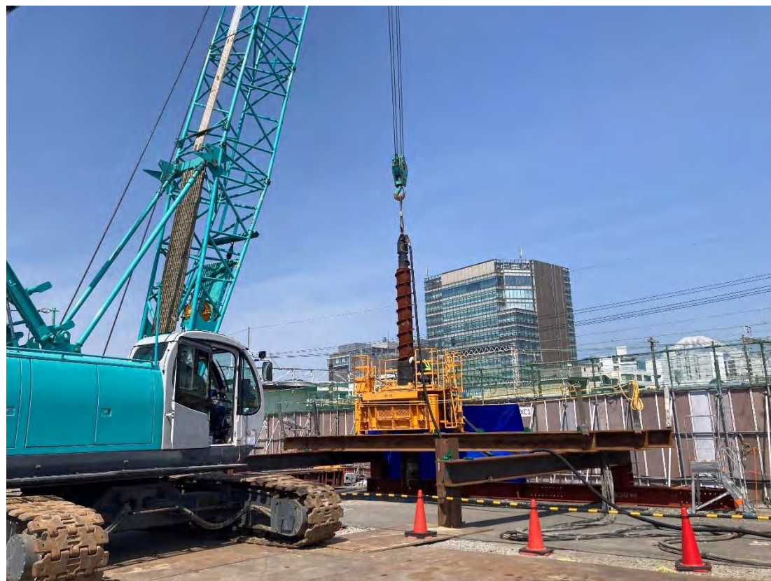
図：ARハンマ工法による山留め工事の施工状況 (2024年4月頃)
