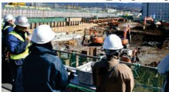
▲基礎の掘削状況の確認の様子
