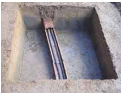
▲通信ケーブルと陶器製トラフ
