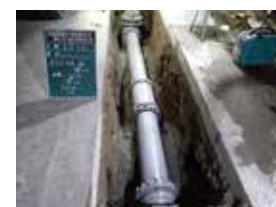
▲耐震管(地震に強い) ※揺れに強く水道管が 抜けない構造
