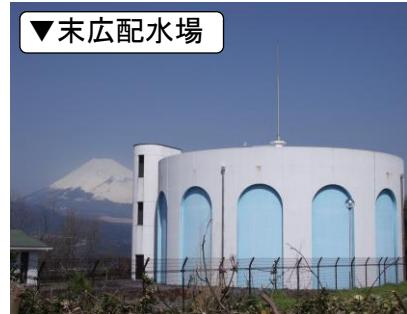
内層 100 m<sup>3</sup> 径 7.0m×6.7m 外層 1,400 m<sup>3</sup> 径 19.0m×6.7m
