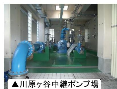
$\phi \ 125\text{mm} \times 1.91\text{m}^3/\text{min}$   $110\text{m} \times 75\text{kw}$  2台
