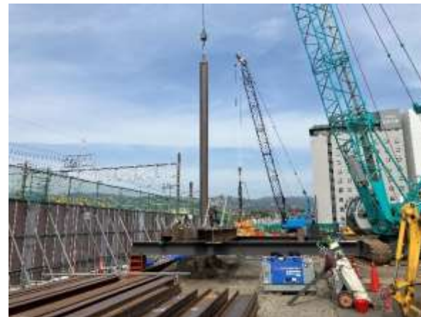
図：H鋼材の打設状況 (2024年4月頃)
