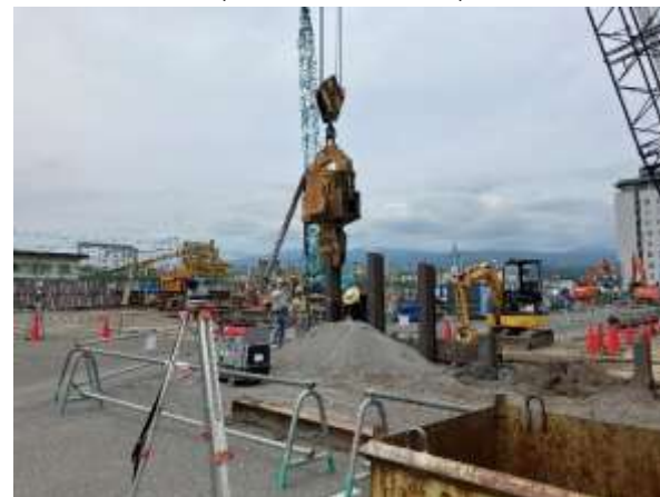
図：H鋼材周囲の埋め戻し状況 (2024年6月頃)
