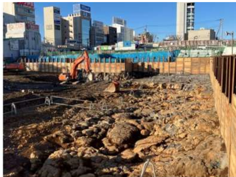
図：親杭横矢板の設置状況 (2024年12月頃)
