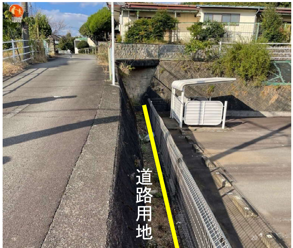
(参考) 道路東側法面
