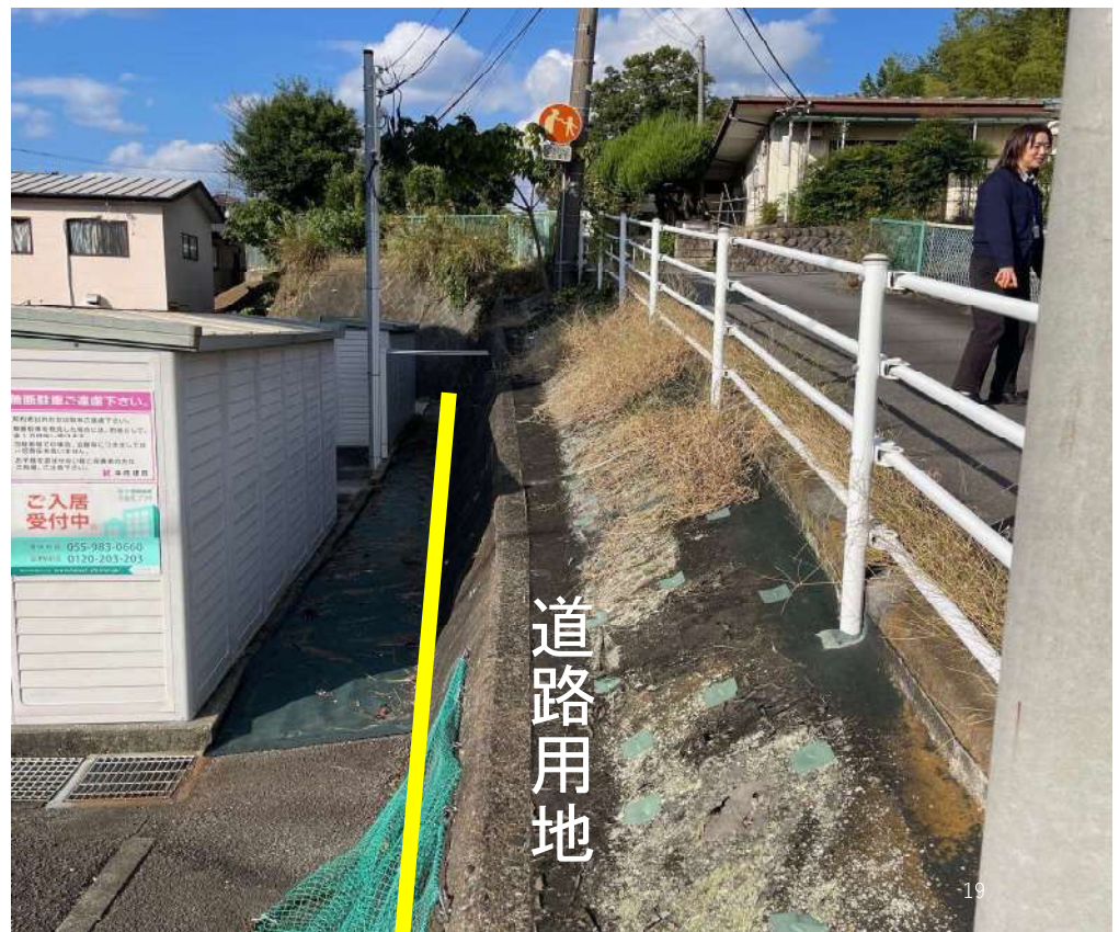
(参考) 道路西側法面
